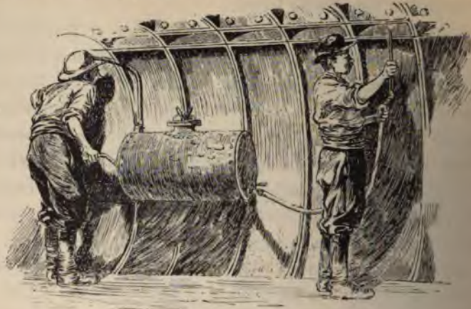
Fig. 255. — Exécution de l'injection.
